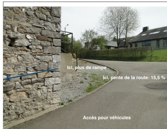
Absence de rampe à l'endroit où elle serait le plus nécessaire
