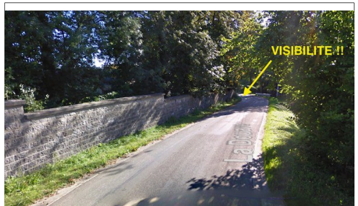
Un manque de visibilité, traversées hasardeuses !
