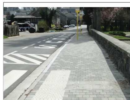
Station de bus règlementaire
