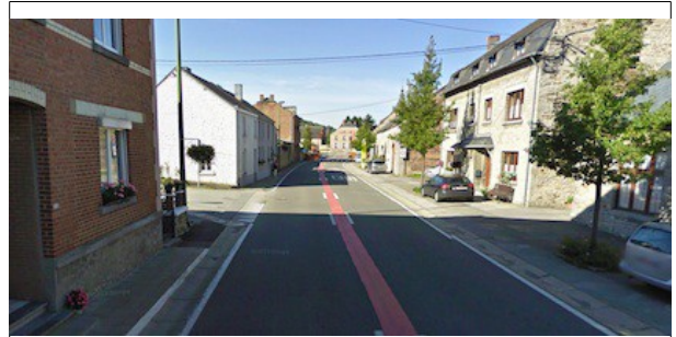
Intégration de la N846 dans la traversée de Bure : il faut repenser le partage de l'espace entre le trafic, le stationnement et les piétons.
