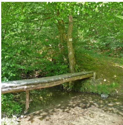
Passerelle sur L'Inson (balade du bois de Machi)
