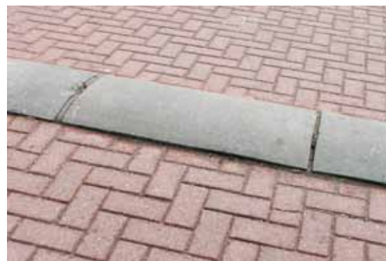
Louvain-la-Neuve, rue A. Chavée. Une différence de niveau également très simple, une bordure collée. Une forte différence de niveau n'est en effet pas toujours possible suivant la configuration des lieux.
