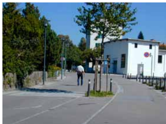
Suisse, Baar. Vu la faible vitesse, les plantations peuvent être placées plus près de la zone de passage, et elles contribuent ainsi à modifier fortement l'image de la voirie traditionnelle tout en aidant les conducteurs à se positionner.
