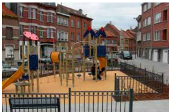
Schaerbeek, rue du Tilleul. L'espace de jeu est protégé par des barrières sans être totalement clos. L'aménagement est toujours visible et ne risque pas de se faire oublier aux yeux des conducteurs.
