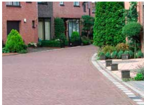
La Haye. Les habitations dessinent l'espace public. La voirie et l'implantation du bâti ont été conçues simultanément.
