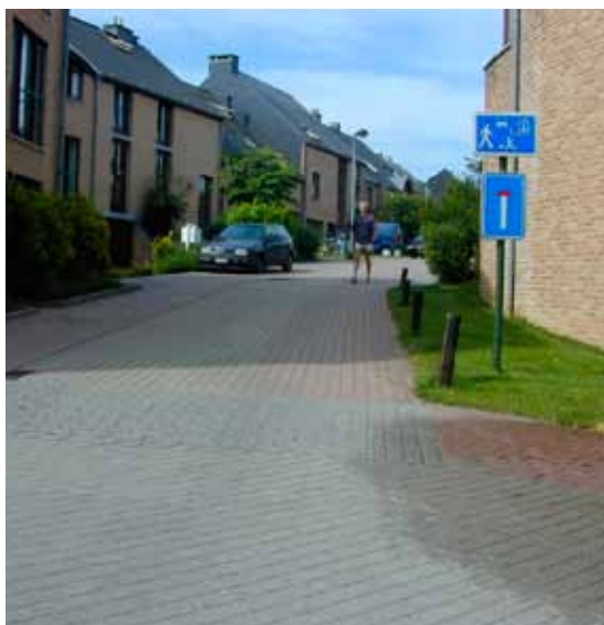
Louvain-la-Neuve. La légère différence de niveau, un simple bombement dans le revêtement.
