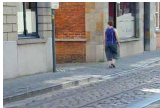
L'entrée de la zone de rencontre est marquée par un trottoir traversant. A Gand, aux entrées du Patershol, quartier entièrement mis en zone résidentielle, toutes les portes d'entrées ont été traitées systématiquement à l'aide de trottoirs traversants.
