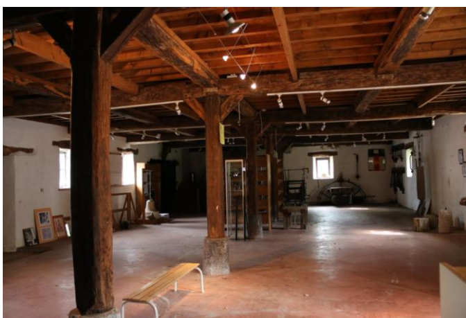
Niveau 1 de l'ancien espace muséographique (partie gauche du bâtiment)
