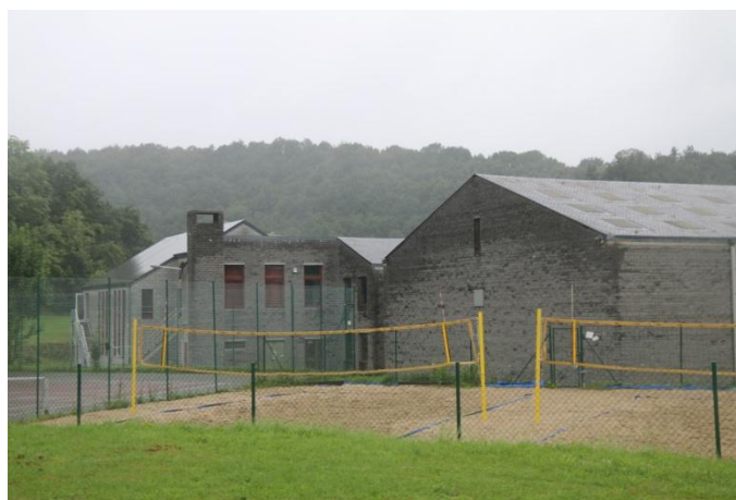
Vue de l'arrière du complexe où sera construite l'extension.
