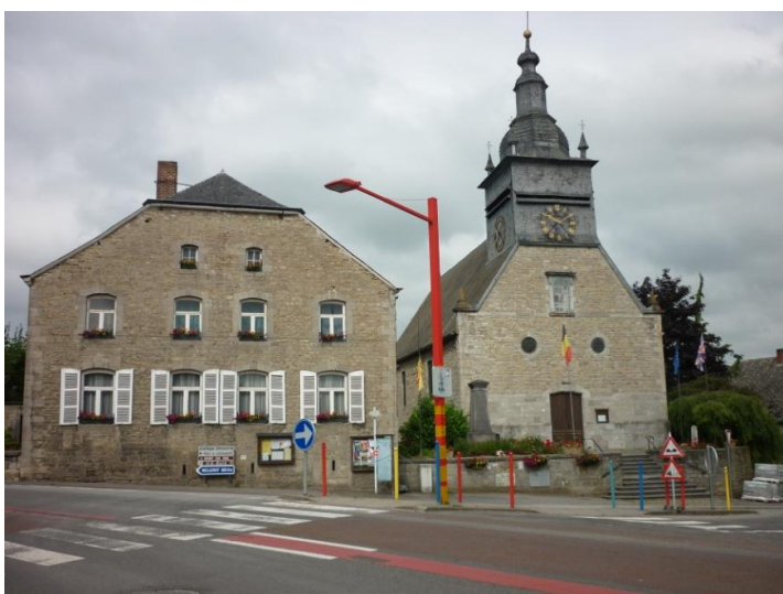
Vue du presbytère
