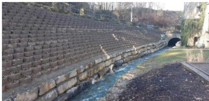
La Commune de TELLIN a réalisé, en partenariat avec la Province de Luxembourg, des travaux de stabilisation des berges du Linçon à Grupont en amont du pont SNCB.
